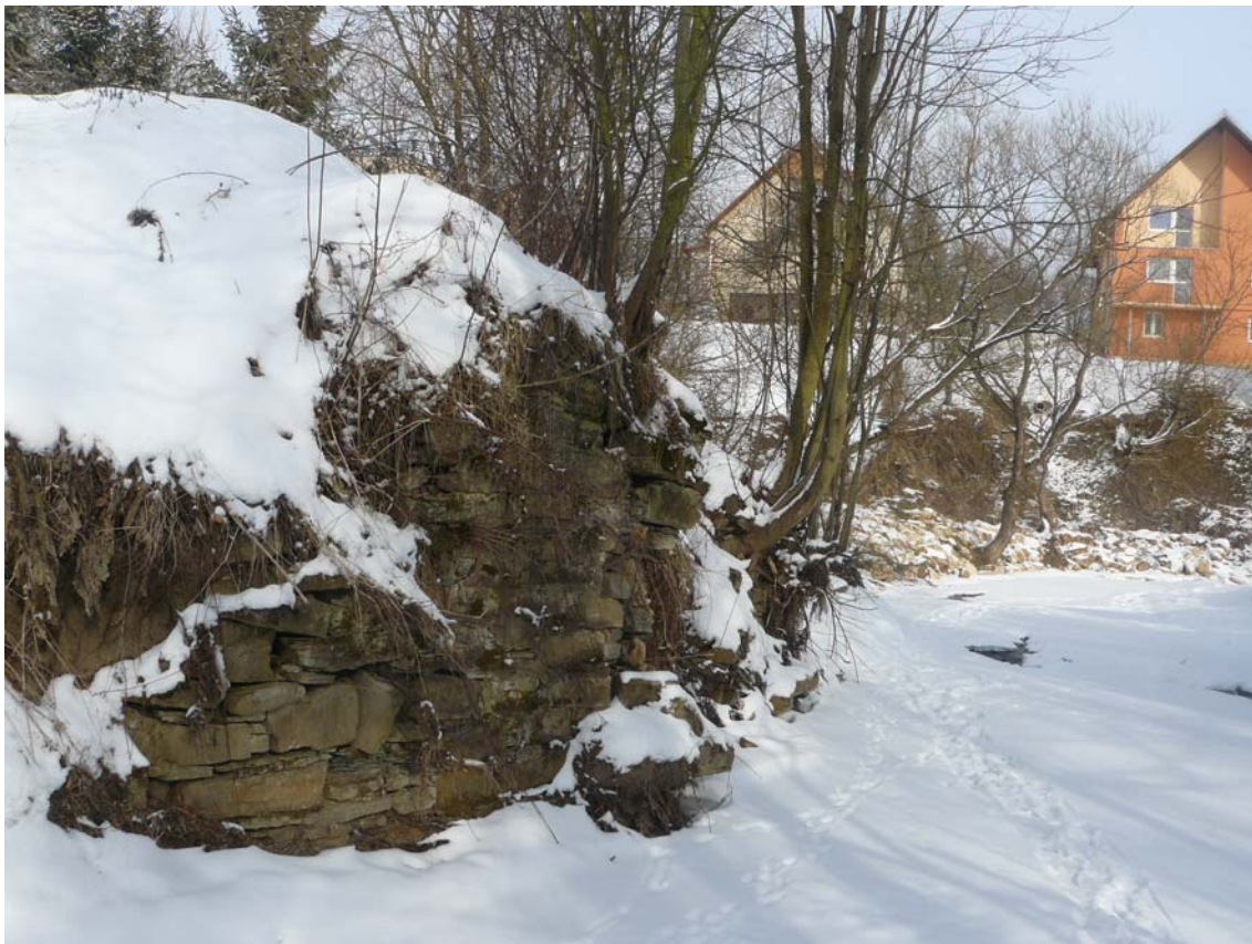
Fotodokumentácia č. 8: Okolie stavebného objektu SO 06 – súčasné opevnenie kamenným múrom
