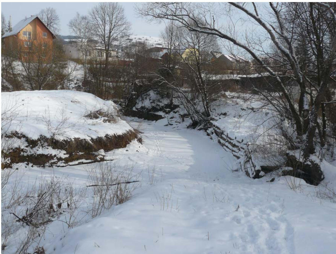
Fotodokumentácia č. 7: Okolie stavebného objektu SO 06 – súčasne zrubové opevnenie svahu
