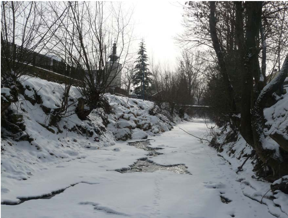
Fotodokumentácia č. 3: Okolie stavebného objektu SO 03 – súčasné opevnenie lomovým kameňom
